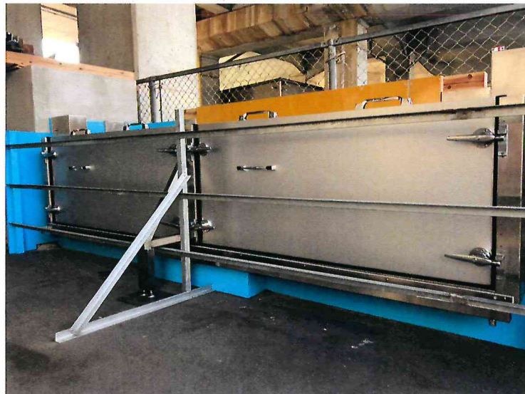
写真3 設置状況全景
