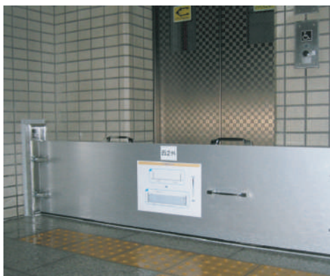
エレベーター前
