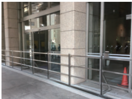
中間柱を床面に差込み、床面に折り畳んであるシートを引上げます
