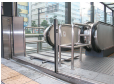
中間柱を床面に差込み、床面に折り畳んであるシートを引上げます
