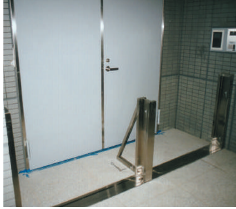
通用口 パネル装着前
