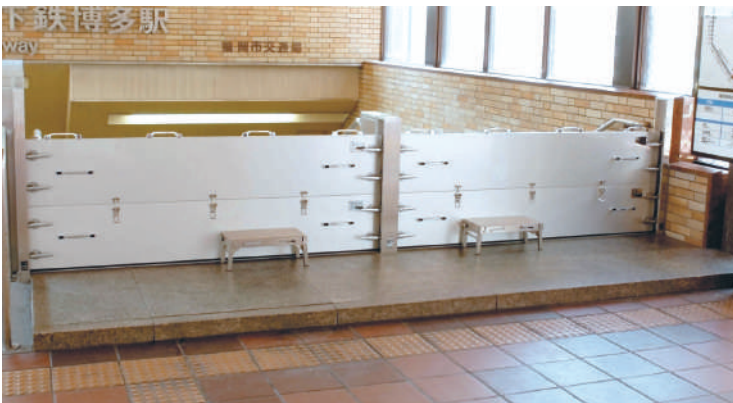
地下出入口階段前(ステップ設置)
