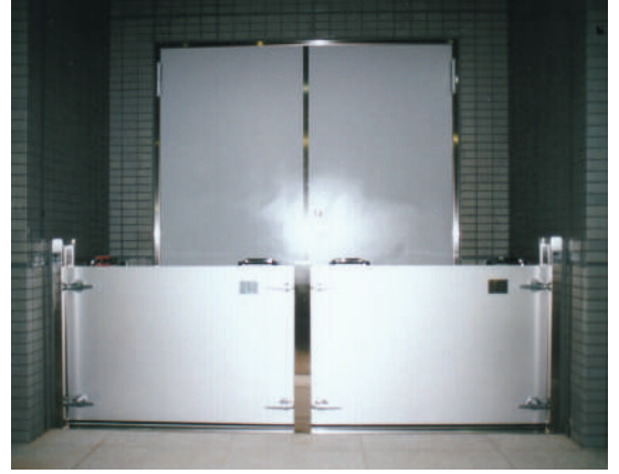
通用口 パネル装着後
