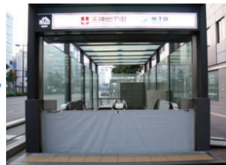
両サイドの取付部分で固定し、中間柱に金具を引っ掛け、取付完了
